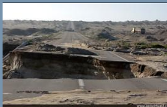
Erosión en el desierto de Atacama, Chile (Foto: W. Griem). - Véase en grande y más
