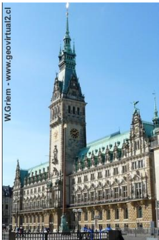
Techo de planchas de cobre oxidado en la alcaldía de Hamburgo (Alemania) - Foto: W. Griem
